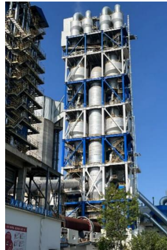
图 3 分解炉现场图片
